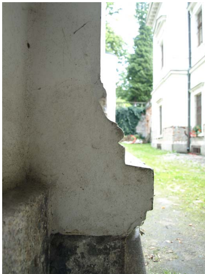
44. průjezd do dvora č. 1.54 – detail patky pilastru „v řezu“
